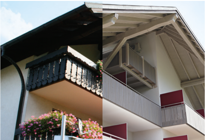
Die dunkle Dachuntersicht wurde optisch an die neue Balkonverkleidung angeglichen.
