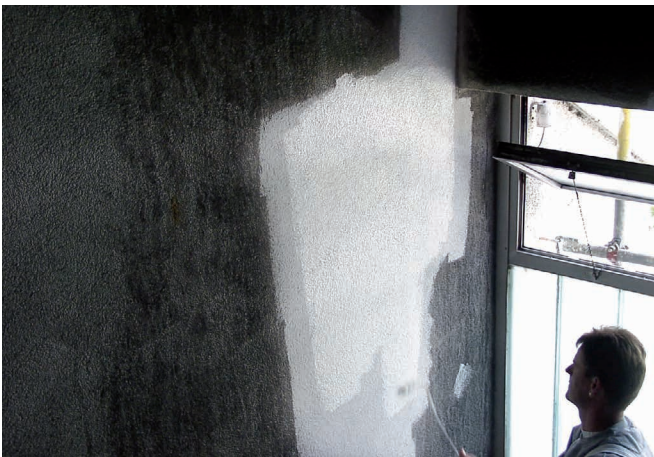
Renovierung eines Brandschadens mit zweimaligem Anstrich
