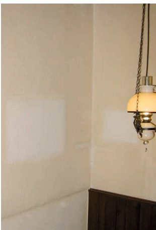
Nikotinverseuchter Untergrund in einer Gaststätte vor und nach einmaligem Anstrich. Direkt nach der Renovierung konnte der Betrieb wieder aufgenommen werden.
