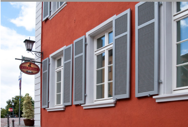
Historische Kalkputze oder hydraulische Putze
