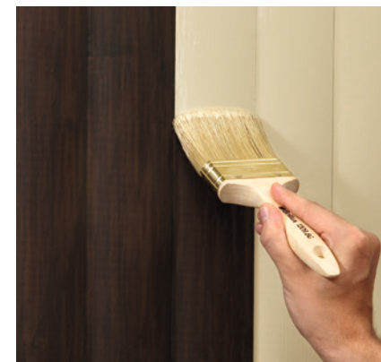
Der dunkel lasierte Untergrund wird mit Impredur Grund 835 im vorgegebenen Farbton abgedeckt.
