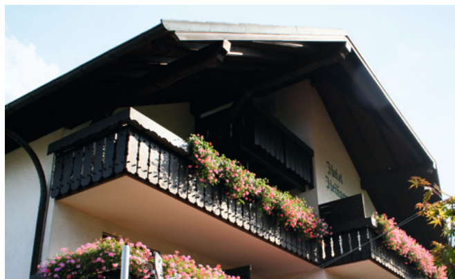
Bestandsaufnahme vor der Renovierung
