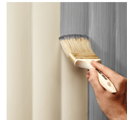
Die Zwischen- und Schlussbeschichtung mit der Dauerschutzlasur 580 wird leicht streifig ausgeführt.
