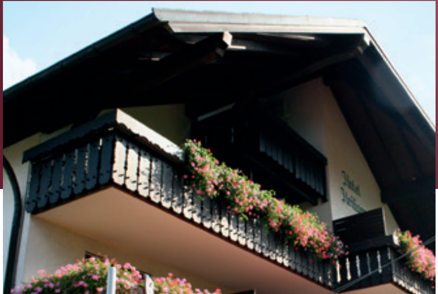
Bestandsaufnahme vor der Renovierung
